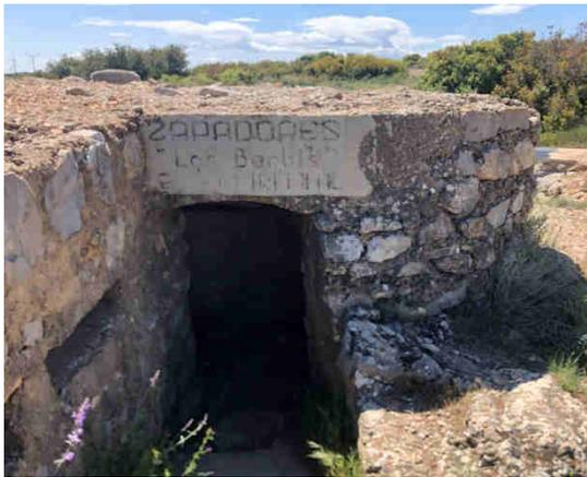
Búnker realizado en hormigón armado, apenas sobresale del nivel del suelo. Es de planta rectangular y cubierta plana, se accede por un lateral formando un recodo. Existen abundantes aberturas para las armas de fuego. Es un ejemplo de la ingeniería militar del momento, realizado en el momento de la ofensiva hacia Zaragoza (según reza la inscripción en el (II año triunfal).
